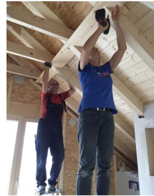
Die fleissigen Hände vom Bauherrn und seinem Team werkeln aber auch im Januar diverse weitere Eigenleistungen, wie das streichen des Holzes mit Holzschutz im Innen, sowie diverse Holzteile vom Aussen. Währenddessen verputzen die Gipser im Untergeschoss die Wände und Decken, der Schreiner montiert die Futter und Verkleidungen der Innentüren und im Dachgeschoss werden die Innenwände fertiggestellt oder für den Abrieb vorbereitet.
