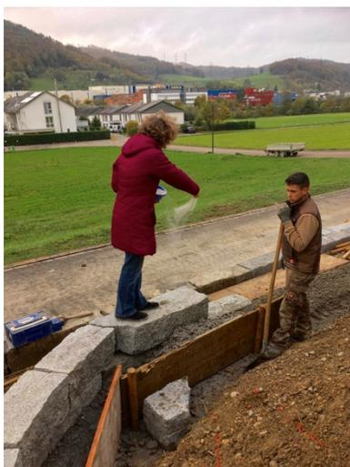
Um das Bord künftig **stabil** zu halten, wurde das Gefälle durch die Verlängerung der bestehenden und das Erstellen zweier neuen Lagen Natursteinmauern minimiert. Die Hinterbetonierung des Granitsteins sorgt für bessere Stabilität gegenüber dem Hangdruck. Der dem Beton beigemischte **energetisierte Quarzsand** hebt die bestehende Bodenenergie an und neutralisiert auch Teile des Elektromogs in der Umgebung.
