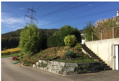
Die **Ausgangslage** war ein bestehendes, steiles, bepflanztetes Bord in einem Einfamilienhaus-Garten, welches ins Rutschen kam. Bereits ergriffene frühere Massnahmen wie Holzfaschinen und mehrmals neue Bodenbepflanzung hielten den Bedingungen des trockenen Südhangs trotz stetiger Bewässerung nicht stand. Immer wieder kam der Humus und der Untergrund ins Rutschen. Im Abstand von ca 30m hinter dem Haus steht eine Hochspannungsleitung.
